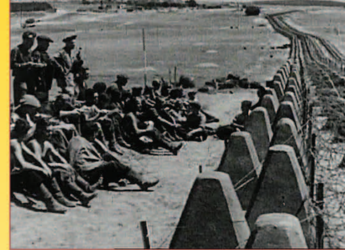
Bauarbeiten an der Höckerlinie - Foto: National Archives
